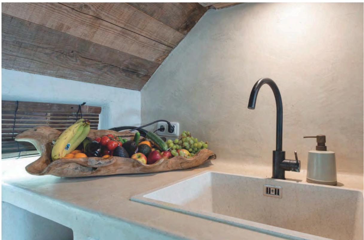
Aanrechtblad en ombouw van het bad zijn in stijl afgewerkt, met Stuc Deco/Stuc Granito; dezelfde mix als voor de vloer is gebruikt.
